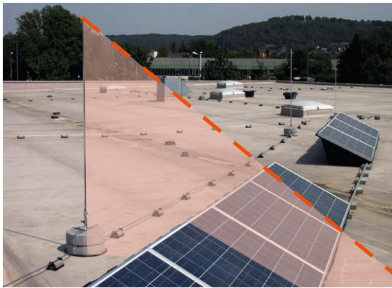
Bild 12 Ermittlung des Schutzraumes mittels Schutzwinkelverfahren
