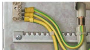
Am zentralen Erdungsblock werden alle Potentialausgleichsleitungen zusammengesgeschlossen.
