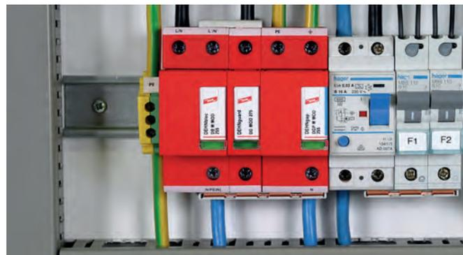
Zum Schutz von Niederspannungs-Verbraucheranlagen vor Überspannungen auch bei direkten Blitzeinschlägen. Zum Einsatz im Blitz-Schutzkonzept an Schnittstellen  $0_A - 1$  in der 3+1-Schaltungsvariante.
