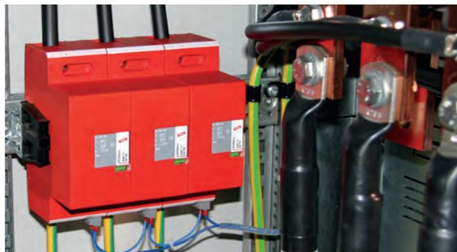
Zum Schutz von Niederspannungs-Verbraucheranlagen vor Überspannungen auch bei direkten Blitzeinschlägen. Zum Einsatz im Blitz-Schutzkonzept an den Schnittstellen 0<sub>A</sub> – 1.
