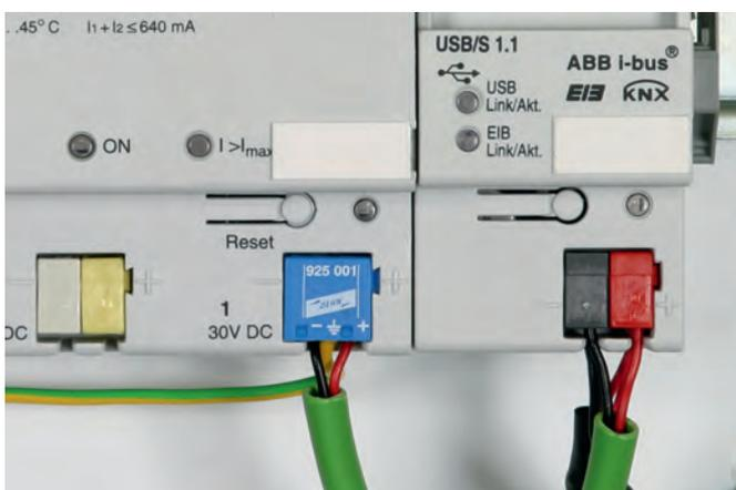
Schutz einer KNX-Spannungsversorgungseinheit mit dem BUSstector. Montage im Standard-Busklemmen-Aufnahmeschacht.
