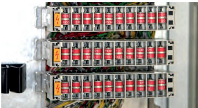
Steckbare Ableiter für LSA-Systeme der Bauform 2/10. Ausführung als Schutzblock für 10 Doppeladern mit einzeln austauschbaren Schutzelementen.
