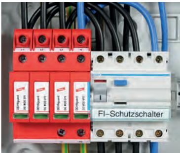
Umsetzung einer EMV-optimalen Durchgangsverdrahtung nach DIN VDE 0100-534 von Blitzstrom- und Überspannungs-Ableitern mittels STAK 2X16.
