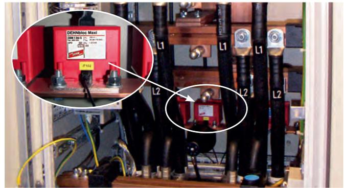
Zum Schutz von Niederspannungs-Verbraucheranlagen vor Überspannungen auch bei direkten Blitzschlägen. Zum Einsatz im Blitz-Schutzkonzept an Schnittstellen  $0_A - 1$ .
