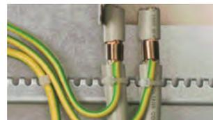
Die Schirme eingeführter Leitungen lassen sich mit Kontaktrollfedern SA KRF platzsparend und blitzstromtragfähig kontaktieren.
