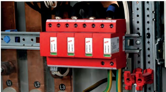
Zum Schutz von Niederspannungs-Verbraucheranlagen vor Überspannungen, auch bei direkten Blitzschlägen. Einsetzbar nach dem Blitz-Schutz-zonen-Konzept an den Schnittstellen 0<sub>A</sub> – 2.
