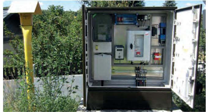
VCSD 40 IP65: Spannungsgesteuerte Abgrenzeinheit mit einstellbarer Ansprechschwelle
