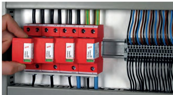
Zum Schutz von Niederspannungs-Verbraucheranlagen vor Überspannungen, auch bei direkten Blitzeinschlägen. Einsetzbar nach dem Blitz-Schutzkonzept an den Schnittstellen  $0_A - 1$  in der 3+1-Schaltungsvariante.
