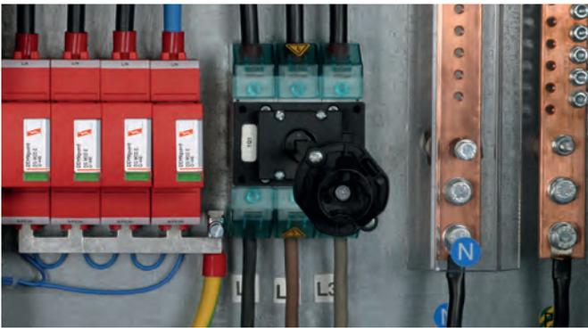
Zum Schutz von Niederspannungs-Verbraucheranlagen vor Überspannungen. Zum Einsatz im Blitz-Schutzzonen-Konzept an Schnittstellen  $O_B - 1$  und höher.
