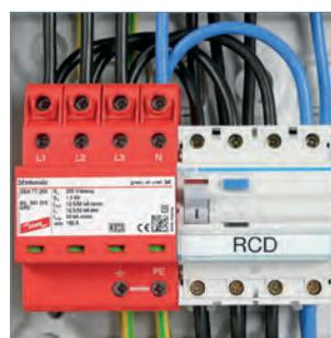
V-Verdrahtung mit blitzstromgeprüfter Stiftanschlussklemme STAK 25.
