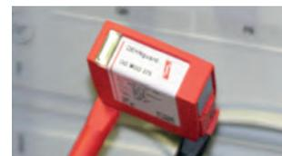
Direkter Anschluss an ein DEHNGuard-Schutzmodul.
