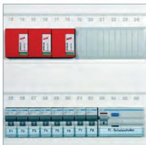
Ein versehentliches Vertauschen der N-PE-Schutzmodule mit dem Funkenstreckenmodul für die Phasenleiter wird durch die mechanische Kodierung am Schutzmodul verhindert.
