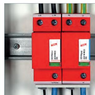
Die betriebsstromfreie Funktions- / Defektanzeige des DEHNbloc M gibt sofort Auskunft über die Betriebsbereitschaft des Gerätes. Neben der standardmäßigen Sichtanzeige mit grün-roter Farbmarkierung stehen dem Anwender mit den Gerätevarianten DEHNbloc M... FM Geräte mit zusätzlichem Fernmeldeausgang zur Verfügung. Durch die Ausführung des Fernmeldekontaktes als potentialfreier Wechsler kann, je nach Schaltungskonzept, das Fernsignalisierungssignal als Öffner oder Schließer verwendet werden.
