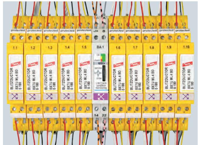
DEHNrecord Condition Monitoring-Einheit in der Installation.
