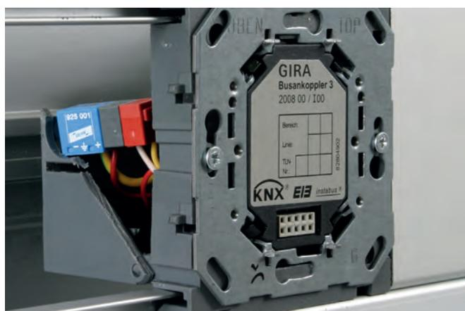
Schutz eines KNX-Busankopplers mit dem BUSstector. Installation an einer Busklemme im Montageraum eines Kabelkanals.
