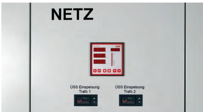
Optische Anzeige für Überspannungs-Schutzgeräte zum Schaltschrankbau.
