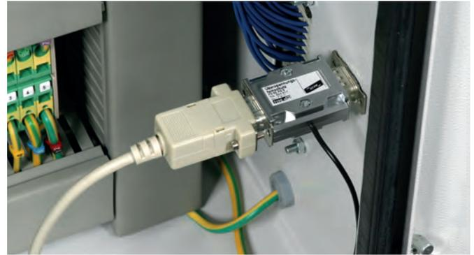
Überspannungs-Ableiter, D-SUB-Steckanschluss in Stecker-Buchse-Ausführung.
