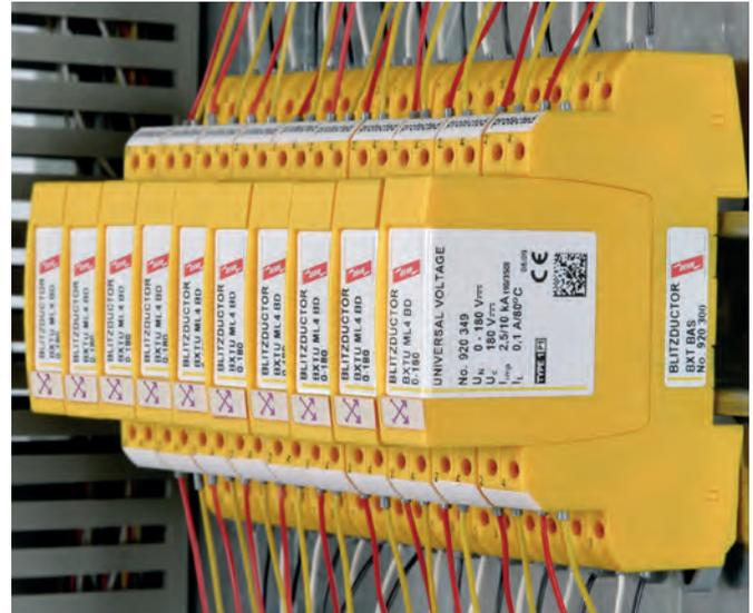
BLITZDUCTOR XTU in der Installation zum Schutz unterschiedlicher symmetrischer Signal- und Datenschnittstellen. Zweiteiliger Aufbau mit Basisteil und Ableiter-Modul in platzsparender Bauweise für Hutschienenmontage.
