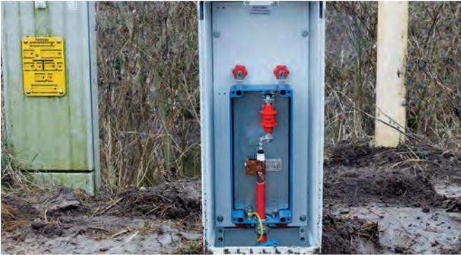
Koaxialer Anschluss der Ex-Trennfunknestecke zum Schutz von unterirdischen Isolierstücken
