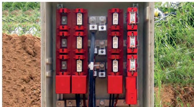
Zum Schutz von Niederspannungs-Verbraucheranlagen vor Überspannungen. Zum Einsatz im Blitz-Schutzkonzept an Schnittstellen 0<sub>B</sub> – 1 und höher. DE-Patent.
