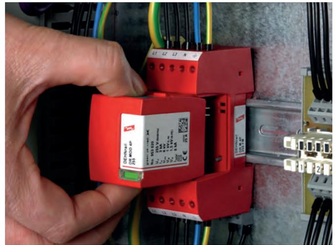
Zum Schutz der Netzversorgung von Geräten der Industrieelektronik vor transienten Überspannungen in Schaltschränken. Zum Einsatz im Blitz-Schutzkonzept an Schnittstellen 1 – 2 und höher.
