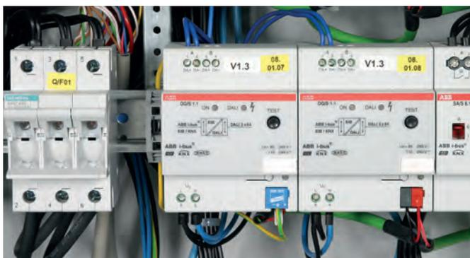
Überspannungs-Ableiter für den KNX/EIB-Bus mit Anschlussdrähten.
