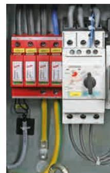
Figure 11: connexion terre supplémentaire du parafoudre à travers le châssis métallique du tableau électrique
