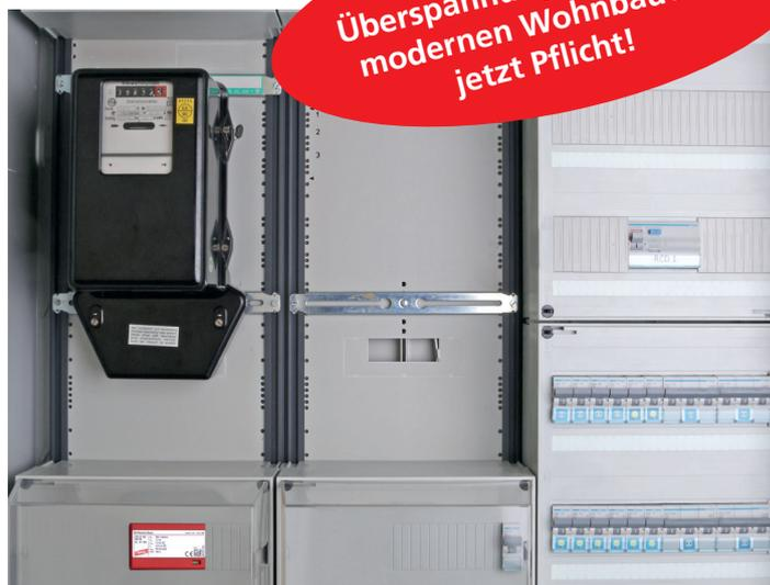
Der Kombi-Ableiter DEHNshield Basic FM eignet sich hervorragend um die neuen Anforderungen gemäß NIN 2020 zu erfüllen. Durch die leckstromfreie Funkenstrecken-Technologie ist die Verwendung des Ableiters im Vorzählerbereich möglich, dadurch wird die elektrische Anlage bereits so nah wie möglich am Einspeisepunkt vor Überspannungen geschützt.
