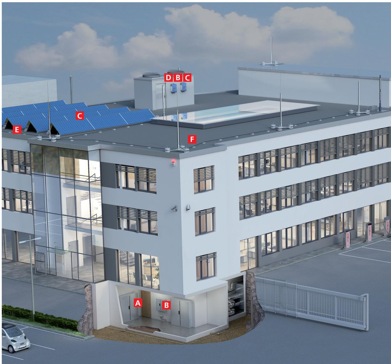
Les modules PV doivent être placés dans le volume protégé du paratonnerre tout en respectant la distance de séparation « s ».
