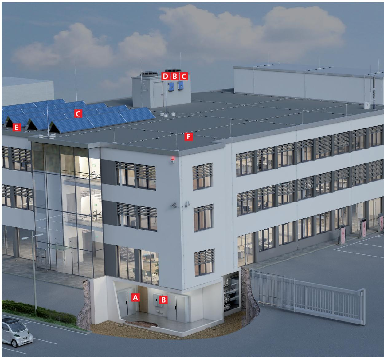
Si la distance de séparation calculée selon NF EN 62305-3 ne peut être maintenue, par exemple entre le paratonnerre et les modules PV, il faut établir une liaison équipotentielle foudre <sup>1)</sup>. Il est impératif de connecter les éléments métalliques aux systèmes de protection contre la foudre et les connexions doivent être en mesure de tenir le courant de foudre.
