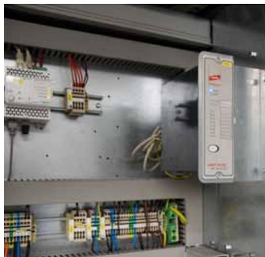
Erfasst Störlichtbögen über Strom- und Lichtsensoren und begrenzt durch die Reaktionszeit von wenigen Millisekunden die Einwirkenergie auf ein Minimum: das Störlichtbogenschutzsystem DEHNshort (im Bild rechts).
