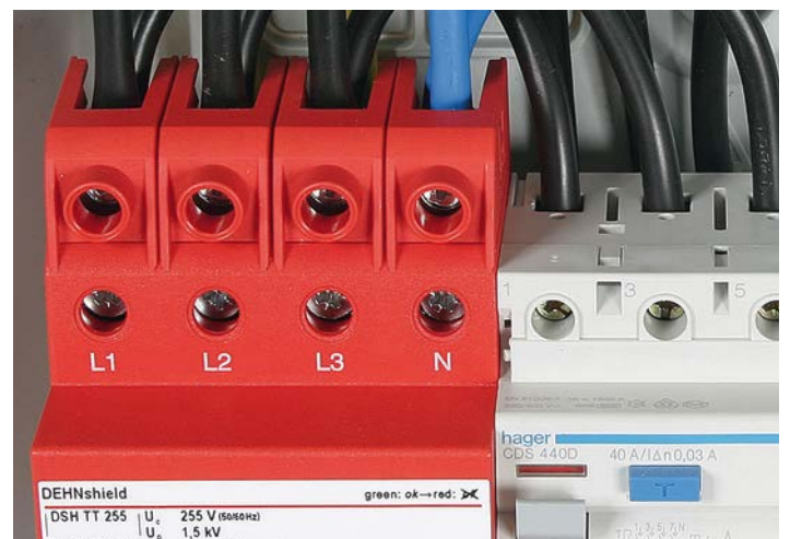
Bild 2: DEHNshield® mit STAK 25 Klemmen in der Anwendung
