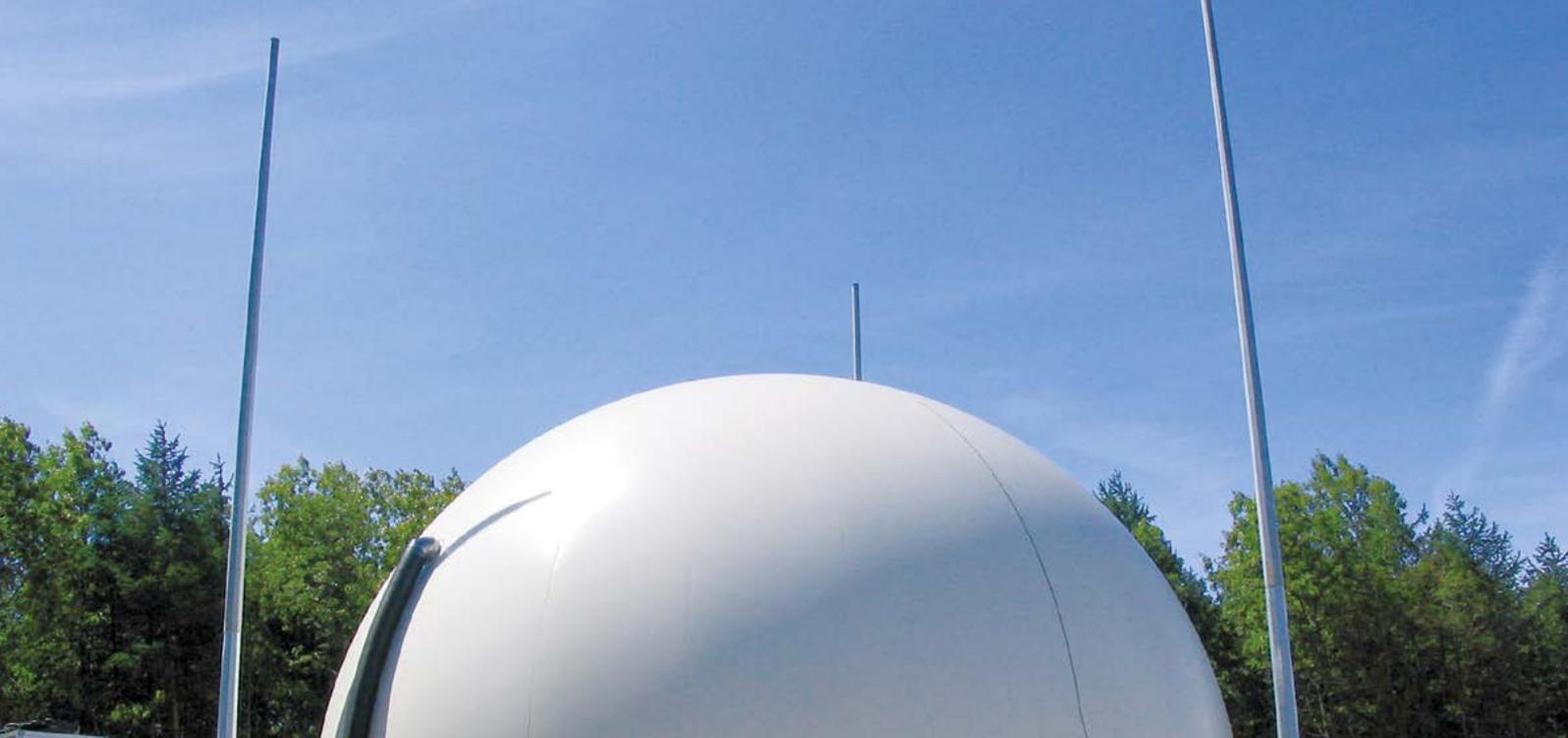
Pour prévenir des impacts foudre directs particulièrement dans le cas de fermenteurs à large diamètre, on utilise des mâts de capture télescopiques. Ce système permet l'intégration des grandes cuves à fort diamètre dans la zone protégée sans nécessiter de fils tendus supplémentaires.
