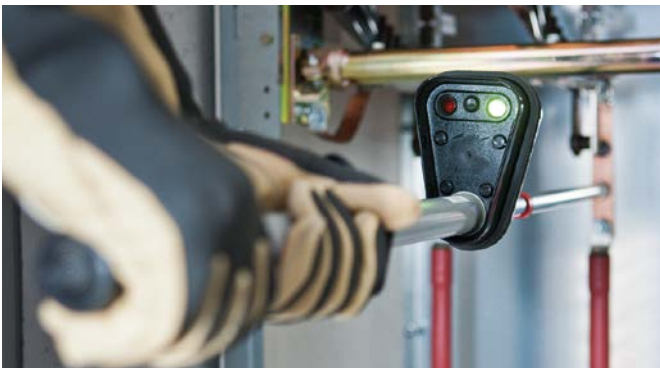
Spannungsprüfer PHE mit optischer Anzeige.
