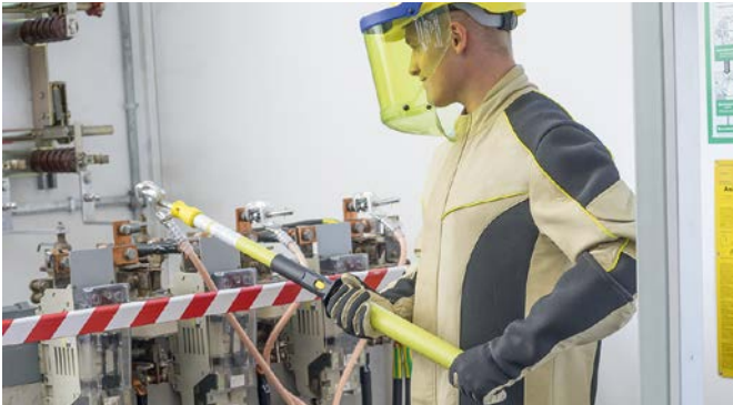
Anbringen einer EuK-Vorrichtung mit der notwendigen Schutzausrüstung.
