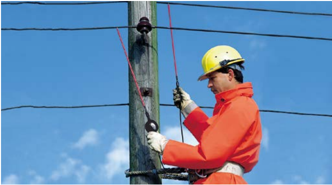
Zweipoliger Spannungsprüfer SPN mit Verlängerungsspitzen in der Freileitung.
