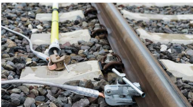
Schienenanschlussklemme am Schienenprofil montiert.
