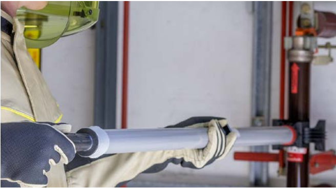
Sicherungsstange SZ zum Einsetzen und Herausnehmen von HH-Sicherungen.
