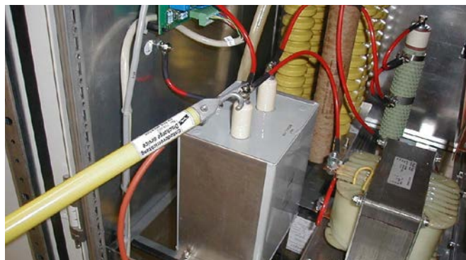
Einpolige Entladevorrichtung zum Ableiten statischer Ladungen.
