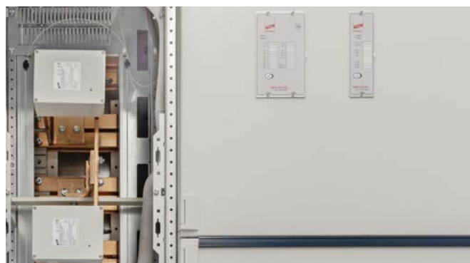
Aktives Störllichtbogenschutzsystem DEHNshort eingebaut in einer Schaltanlage.
