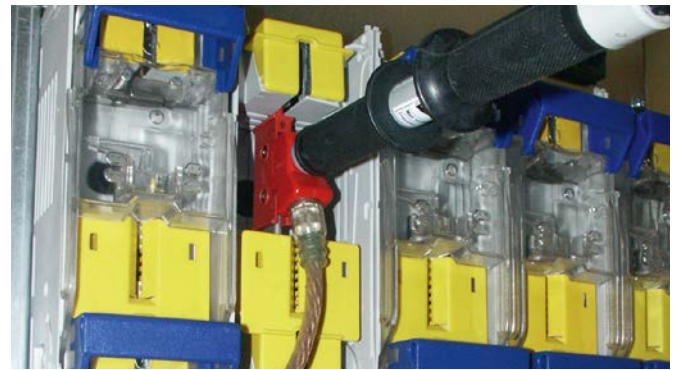
Einsetzen der vollisolierten Erdungs- und Kurzschließvorrichtung mit Hilfe des Erdungsgriffes VI.
