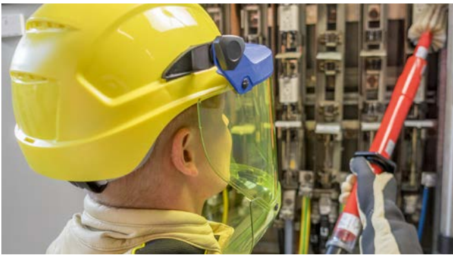
Monteur mit notwendiger Schutzausrüstung.
