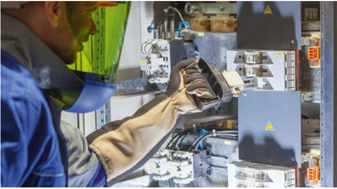
Betätigung eines NH-Aufsteckgriffes mit dem Schutzhandschuh.
