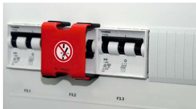
Sperrelement mit 3 Teilungseinheiten (3 TE).
