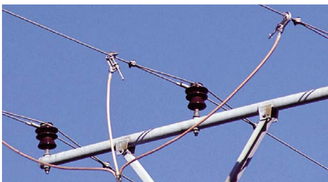
Phasenschraubklemmen in der Freileitung.
