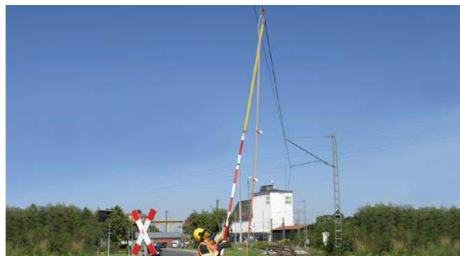
Einhängen einer Bahnerdungsvorrichtung.
