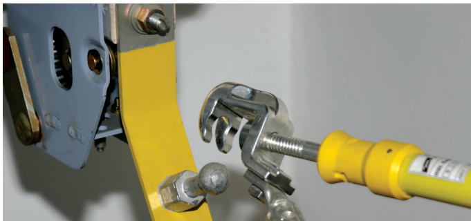
Montage einer E+K-Vorrichtung mit Uniklemme für Kugelfestpunkte 20 oder 25 mm
