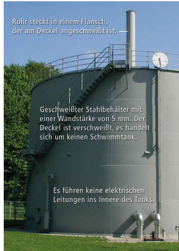
Bild 8 Geschweißter Stahlbehälter (Quelle: Eisenbau Heilbronn GmbH)
