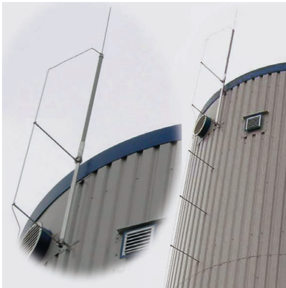
Bild 7 Schutz des Gärbehälters aus Metalltafeln mit isolierter Fang-einrichtung (Quelle: Büro für Technik, Hösbach)
