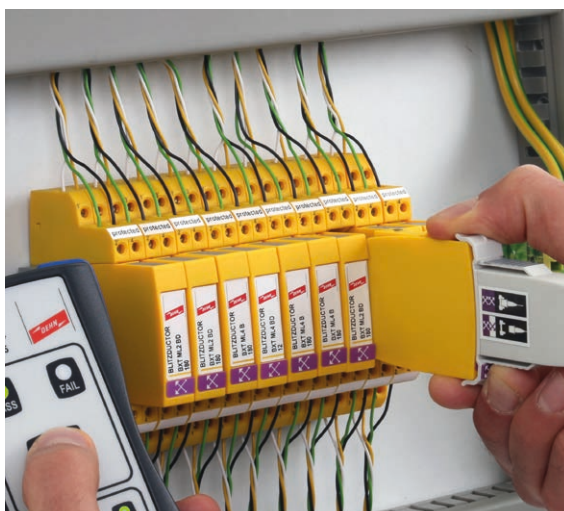
Bild 12 Kombi-Ableiter-Module mit LifeCheck
