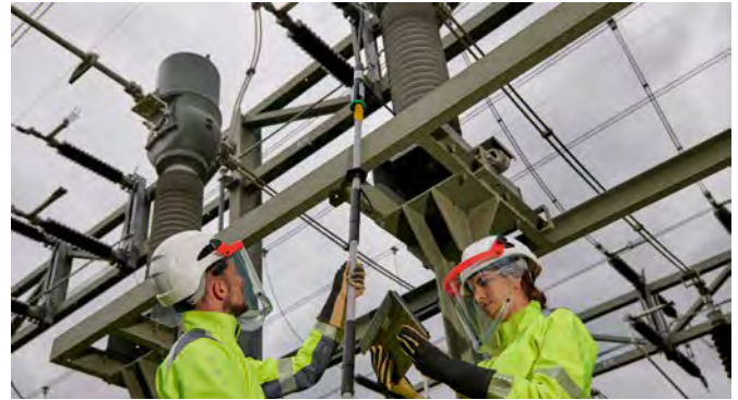
Abstands-Spannungsprüfer ASP in einer Freiluftschaltanlage.
