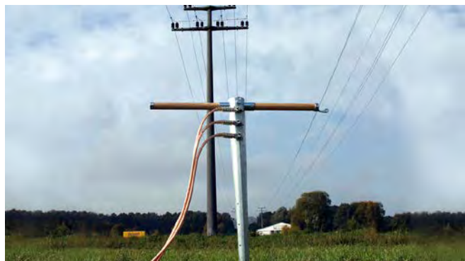
Erdungsrohr mit montierter Erdungsschiene und Erdungsseilen.
