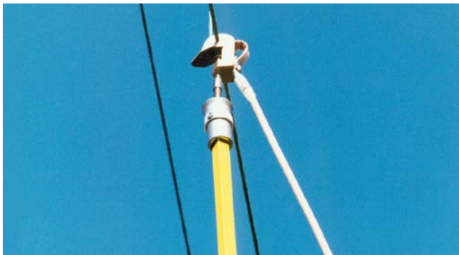
Einhängen der Fahrdrabt-Erdungsklemme in den Fahrdrabt.
