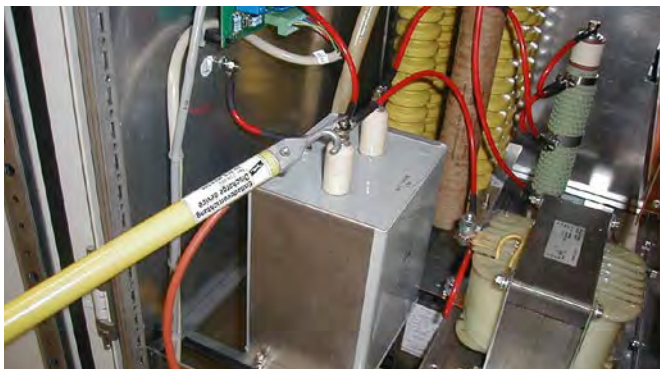
Einpolige Entladevorrichtung zum Ableiten statischer Ladungen.
