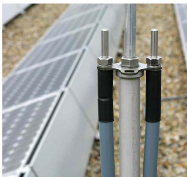
**Conducteur de descente HVI® de DEHN : exploitation efficace, tout en protégeant l'installation photovoltaïque**
