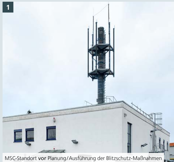
MSC-Standort vor Planung/Ausführung der Blitzschutz-Maßnahmen
