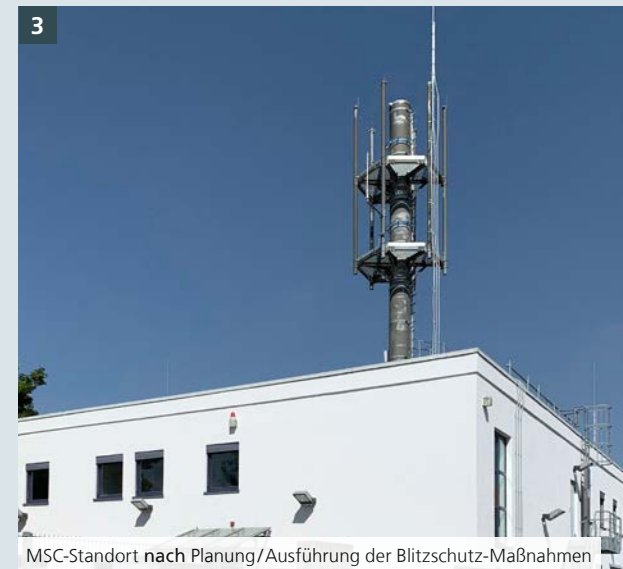
MSC-Standort nach Planung/Ausführung der Blitzschutz-Maßnahmen
