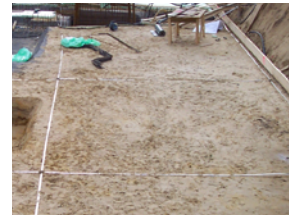
Vermaschter Ringerder unter der Bodenplatte eingebracht
