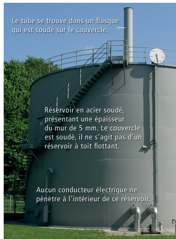
Figure 9.3.8 Réservoir soudé en acier (source : Eisenbau Heilbronn GmbH)
