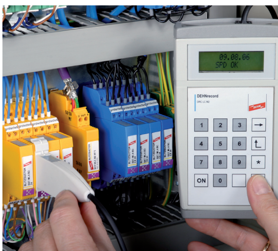
Figure 9.3.12 Modules d'un parafoudre combiné avec LifeCheck
