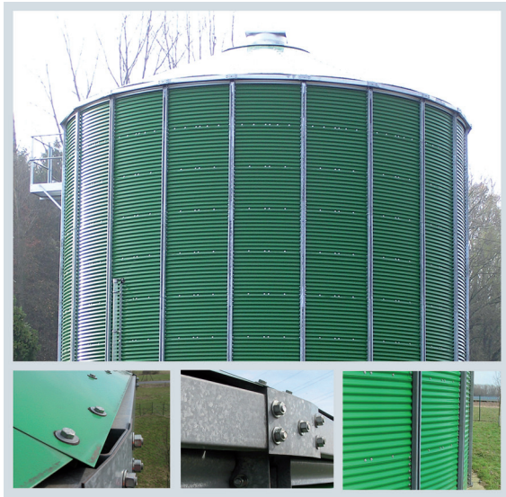
Figure 9.3.6 Digesteur en panneaux métalliques vissés
