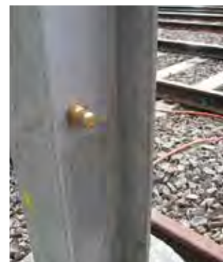
Éclateur type SDS à installer dans un adaptateur de rail Siemens-No. 8WL6503-xx
