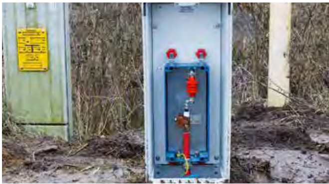
Raccordement coaxial de l'éclateur d'isolement Ex pour la protection des pièces isolantes souterraines
