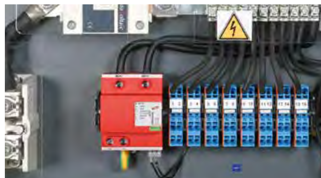
Pour la protection des onduleurs photovoltaïques contre les surtensions même en cas d'impacts de foudre directs. Pour une utilisation selon CEI 60364-7-712: « Règles pour les installations et emplacements spéciaux – alimentations photovoltaïques (PV) »
