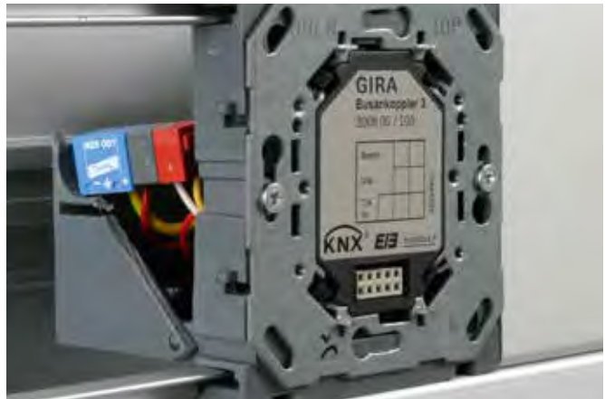
Protection d'une unite de couplage bus KNX avec BUSstector. Installation directe sur l'unité de couplage encastrée dans une goulotte.
