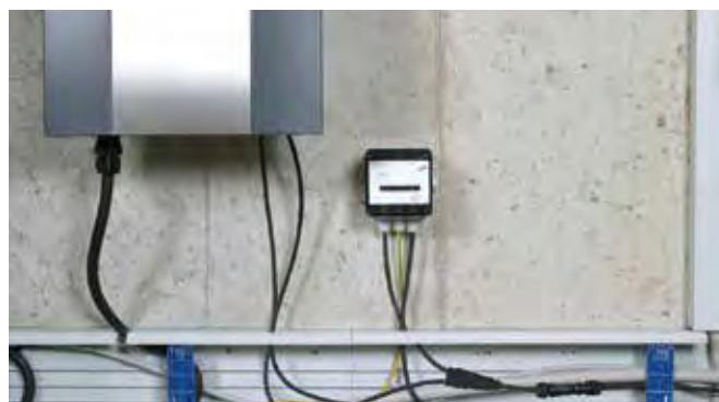
Câbles de raccordement préconfectionnés pour un raccordement simple des strings au parafoudre DEHNcube et à l'onduleur.
