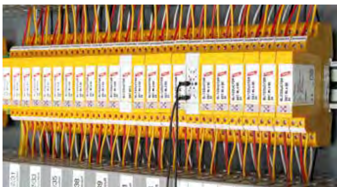
BLITZDUCTOR XT avec un module de mise à la terre intégré (gris). Le signal peut être mesuré sans l'interrompre.
