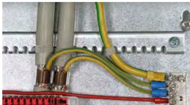
Système de connexion particulièrement peu encombrant sous la forme d'un ressort de contact. Compensation du fluage des matériaux du câble grâce à la pression du ressort.
