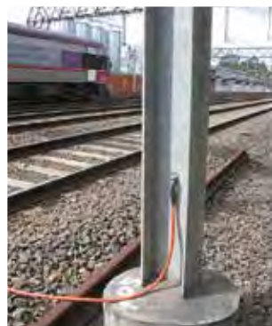
Éclateur type SDS à installer dans un adaptateur de rail Siemens-No. 8WL6503-xx
