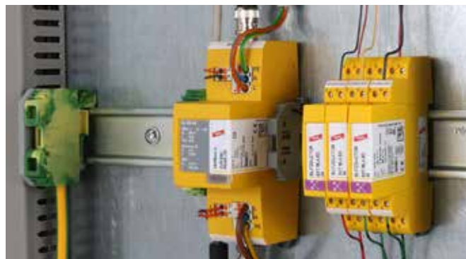
Parafoudre 3 en 1 optimisé à encombrement réduit DEHNvario pour systèmes de caméras analogiques.
