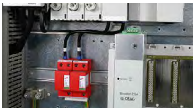
Assure la protection des installations à courant continu contre les surtensions, même en cas d'impacts de foudre directs. Utilisation selon le concept des zones de protection contre la foudre aux interfaces O_A - 1 .
