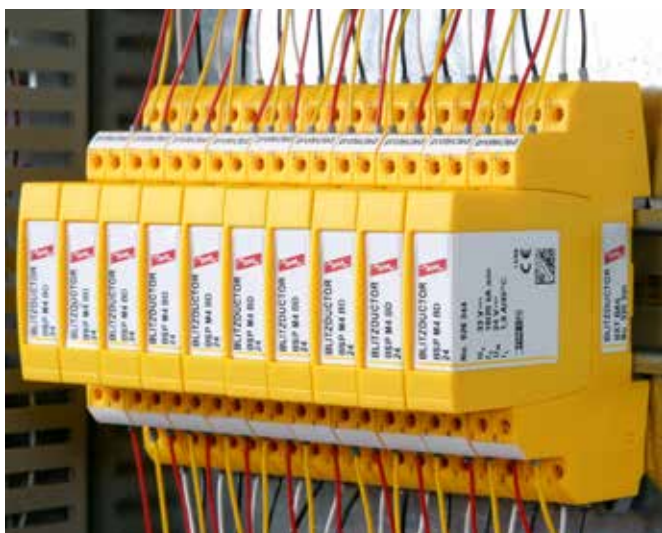
Parafoudre universel débrochable multipolaire pour les réseaux de données.
