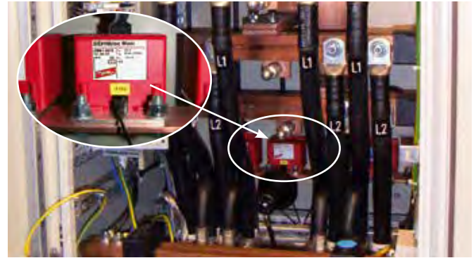
Pour la protection des distributions et des installations à basse tension contre les surtensions, même en cas d'impacts de foudre directs. Utilisation selon le concept des zones de protection contre la foudre aux interfaces O_A - 1 .
