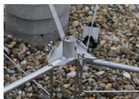
**Possibilité de raccorder jusqu'à 6 conducteurs**
